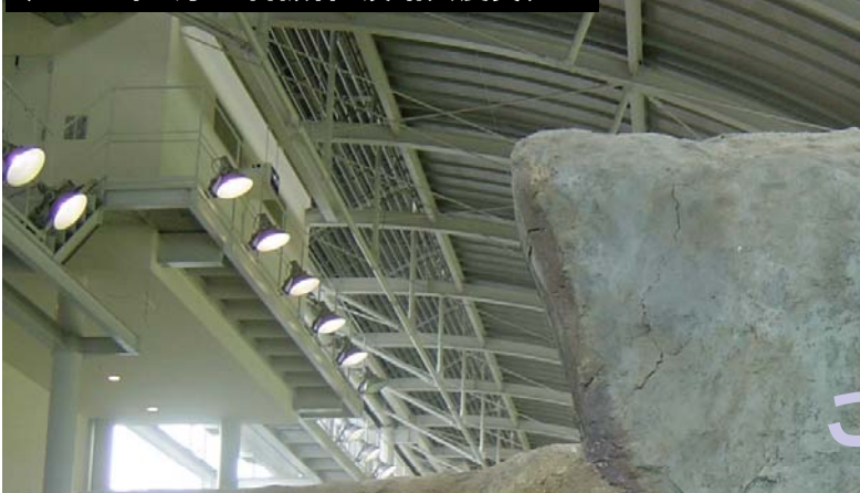
淡路島北淡町で保存されている野島断層 (1995年1月17日阪神・淡路大震災)
